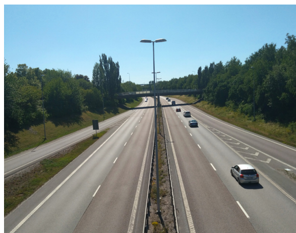
Figur 26. Bärbyleden västerut sett från gång- och cykelbro i Tunabackar.
